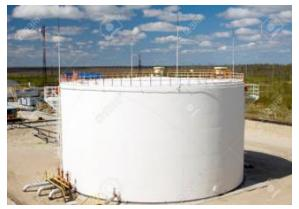
**Capacité d'un réservoir :** Capacité d'un réservoir définie par le volume de remplissage correspondant au premier niveau de sécurité, à défaut au niveau de débordement.
