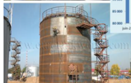
Sous-couche sur bac avant Revêtement isolant « Masticat 3000 »
