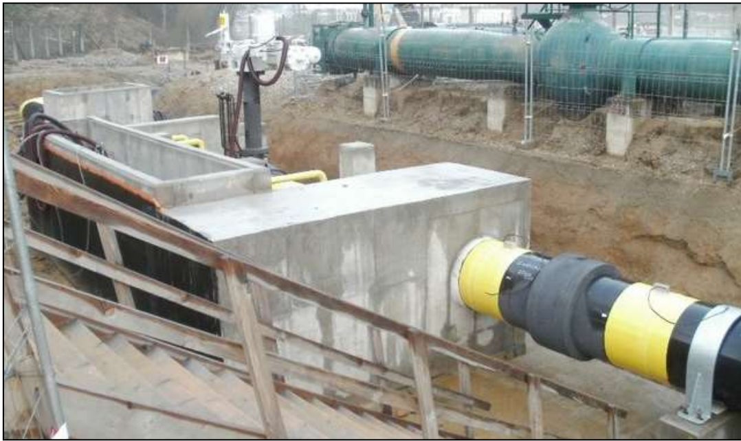
Figure 7. Enterrement d'une vanne de mise en sécurité.
