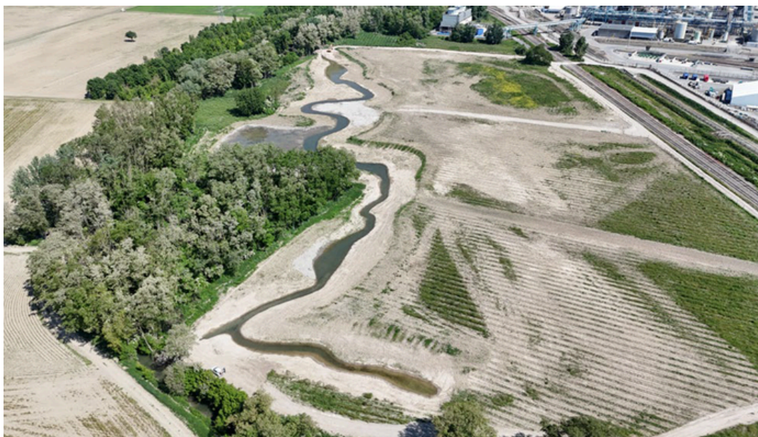
Vue aérienne de l'état d'avancement en mai 2025
