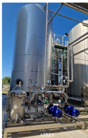
Mise en place de l'unité d'osmose inverse
