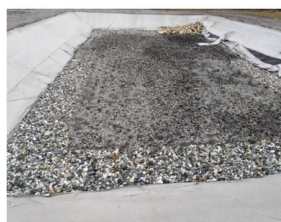
Photo filtre planté au 14/01/2021 (premières pousses)
